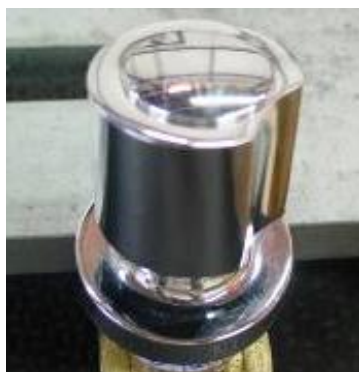
Falta de identificação do fabricante no registro de gaveta
